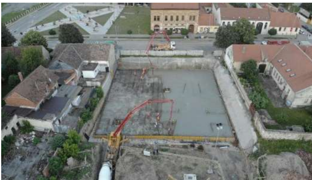
Slika 1. Izlijevanje temeljne betonske ploče
