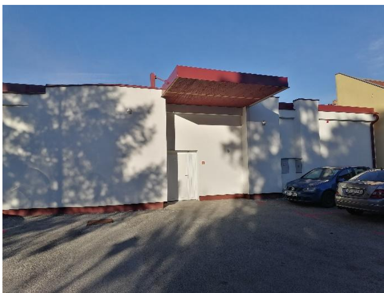
Slika 16. Novo spremište Knjižnice u dvorištu Školske ulice br. 4
