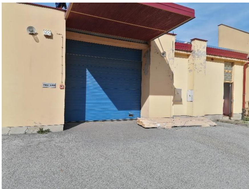
Slika 13. Zgrada namijenjena spremištu Knjižnice prije obnove
