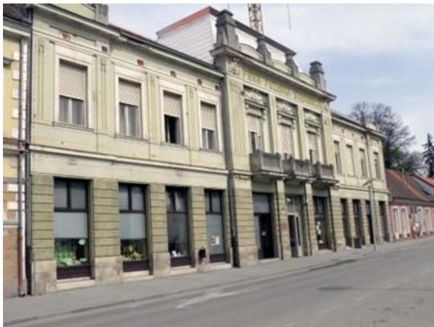
Slika 2. Zgrada Gradske knjižnice i čitaonice Požega prije adaptacije i dogradnje
