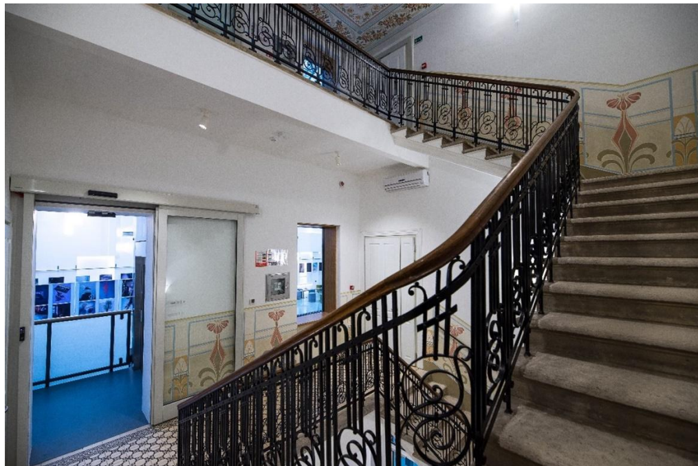
Slika 9. Obnovljeni stari dio zgrade i dograđeni novi
