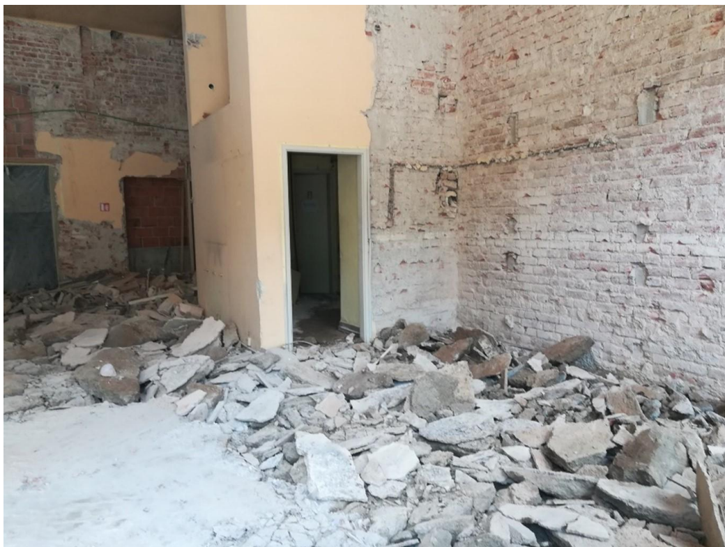
Slika 8. Adaptacija unutrašnjeg prostora stare zgrade iz 1907.
