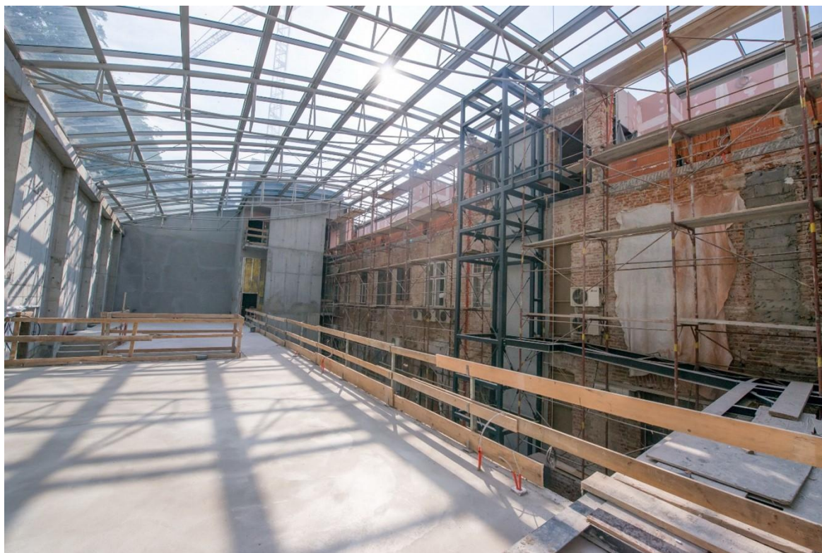
Slika 6. Dvorište knjižnice tijekom gradnje
